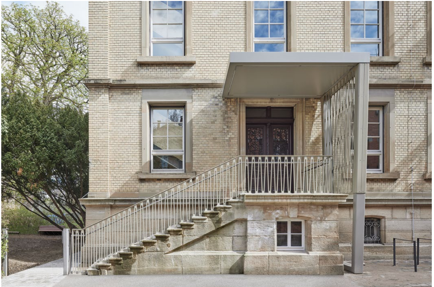
Bild 1. Neuer Zugang mit sanierter Sandsteintreppe und Vordach
