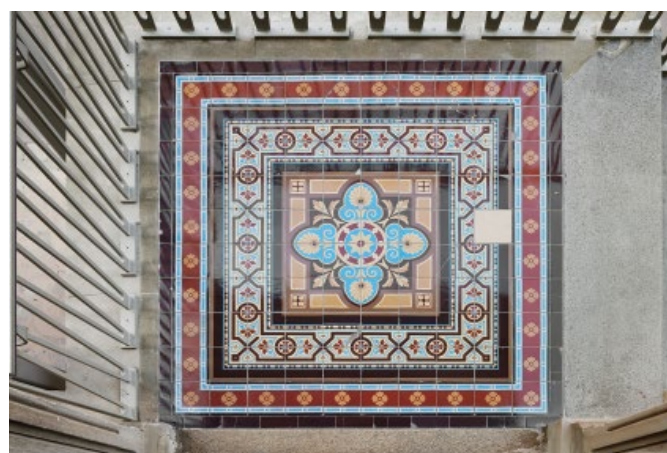
Bild 3. Mosaikboden im Hauseingang
