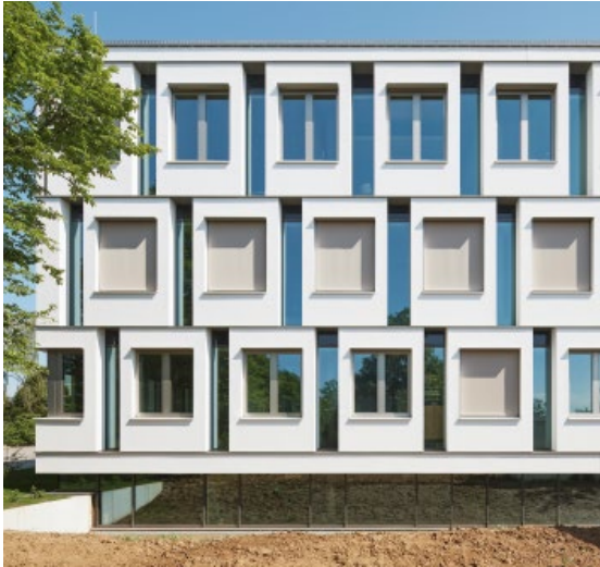
Bild 4. Die einzelnen plastischen Fassadenmodule sind außen mit Glattputz versehen und mit einer transparenten Fuge aus Glas getrennt.
