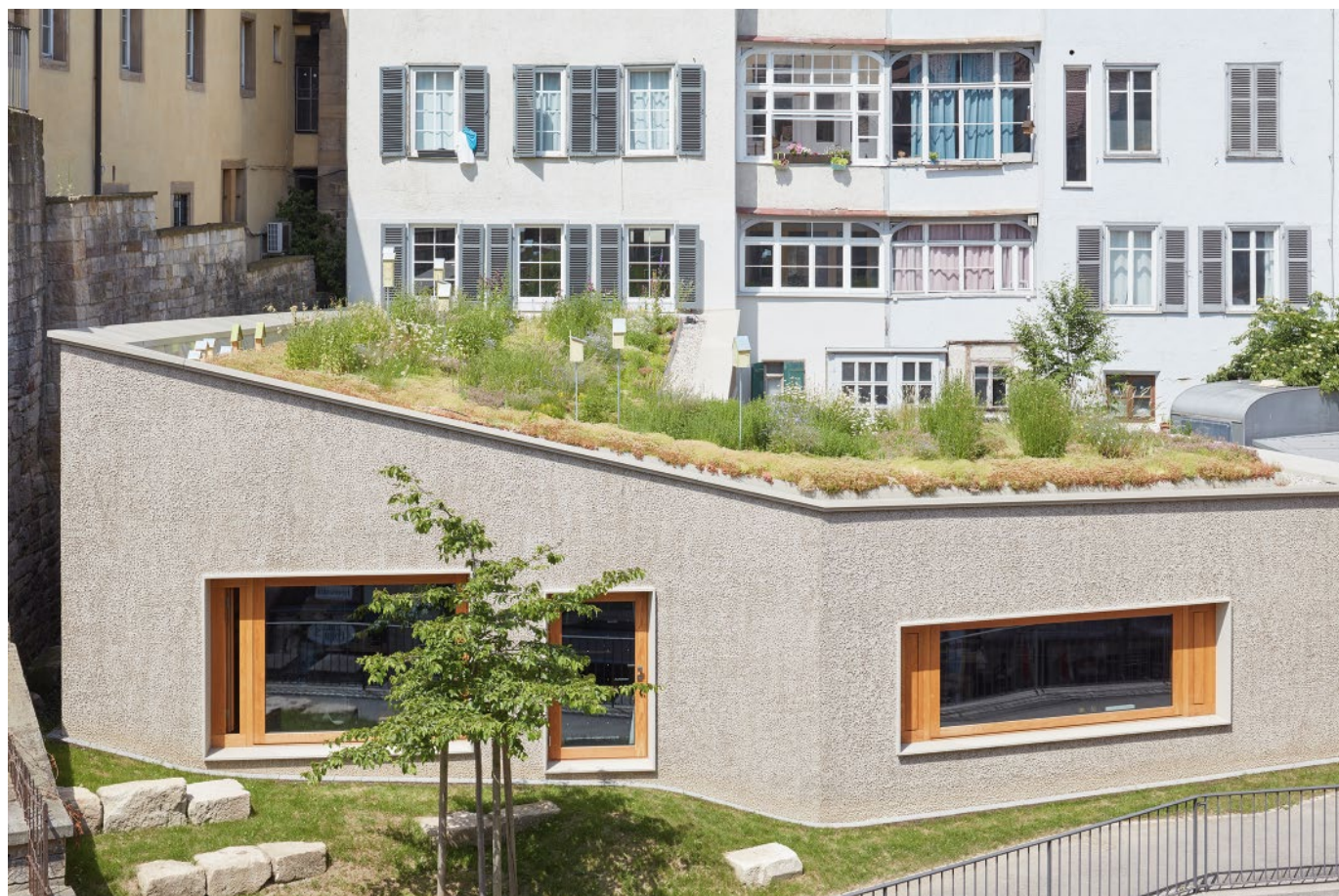
Bild 1. Ladenumbau und Büroneubau in der Tübinger Altstadt. Der Neubau setzt sich in seiner modernen und klaren Formsprache deutlich vom Altbau ab.
