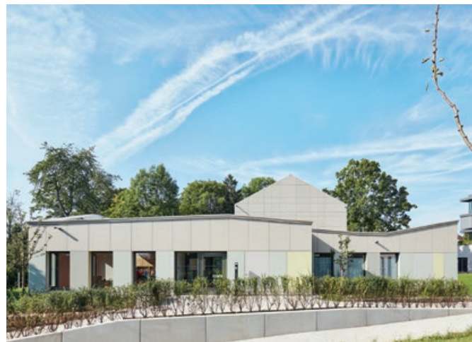
Bild 4. Die mehrfache Faltung des begrüntes Daches ist an der unterschiedlichen Traufhöhe von außen ablesbar. Das schafft differenzierte Innenräume.
