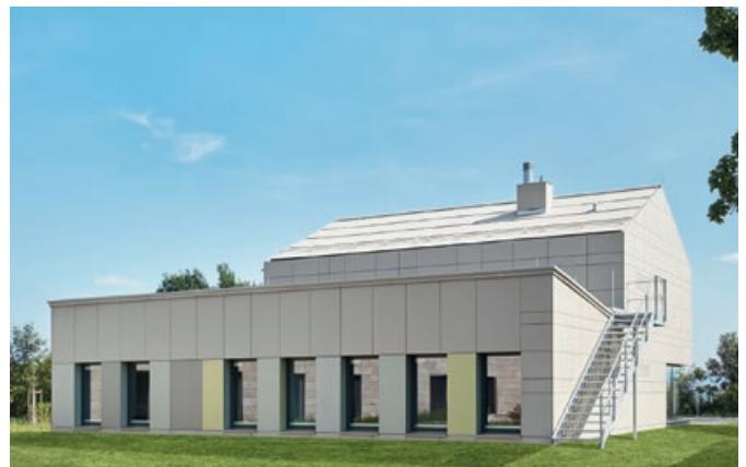
Bild 2. Der Anbau wickelt sich eingeschossig um den Bestandsbau herum.
