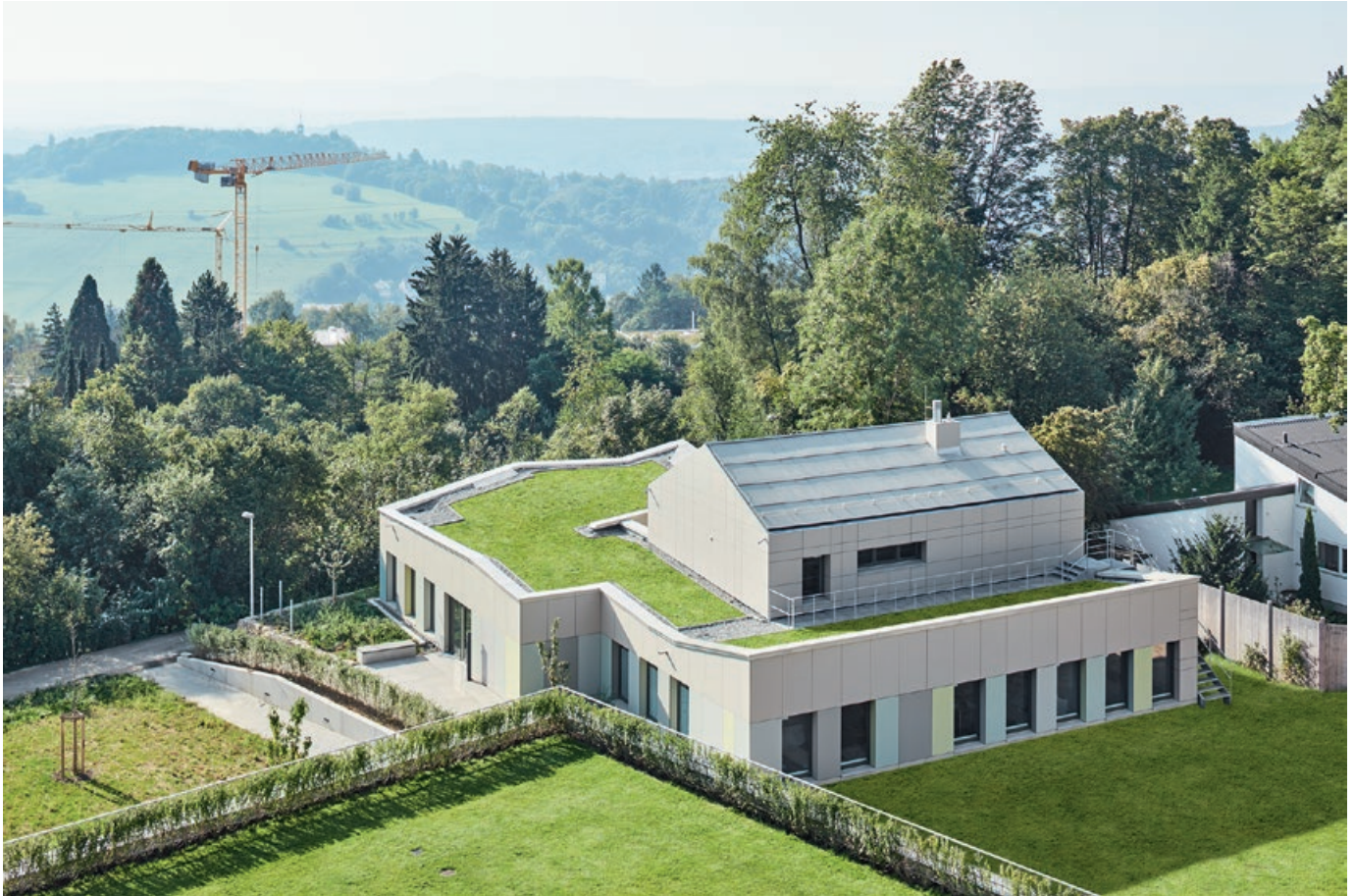
Bild 1. Kita „Planckton“: Der Anbau ist eingeschossig in Holzständerwerkbauweise um den massiven zweigeschossigen Bestandsbau herumgewickelt.
