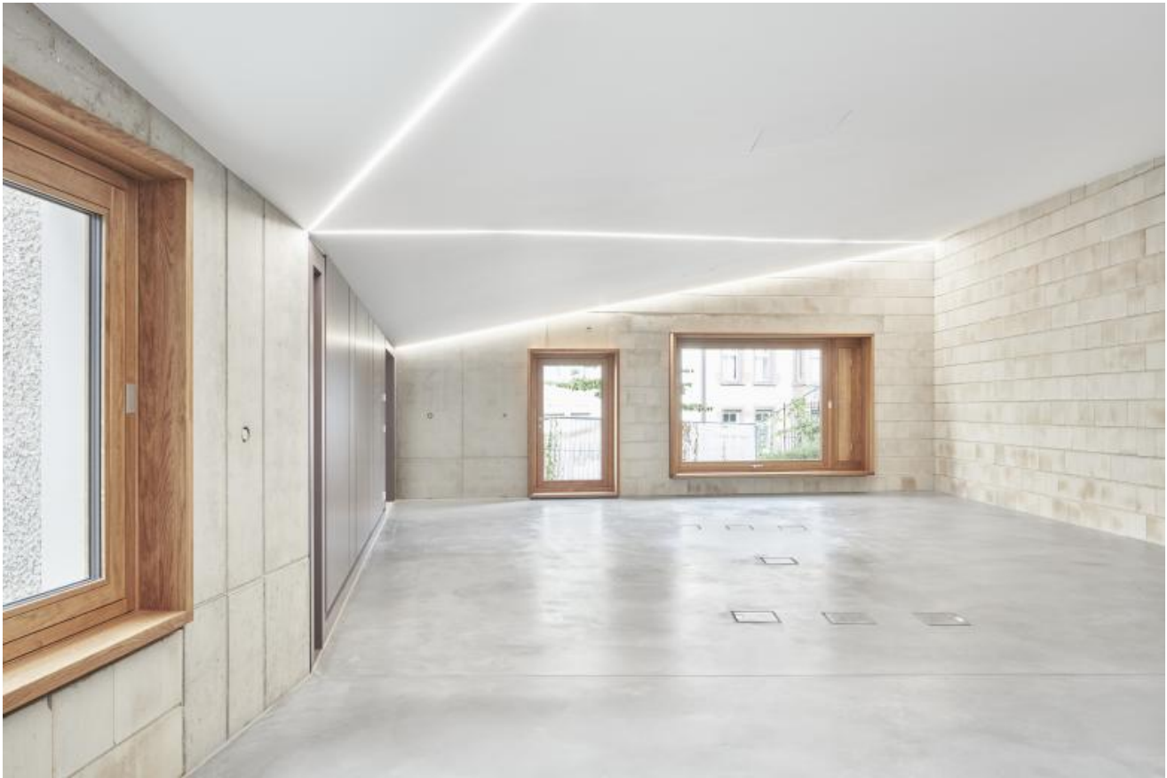
Nüchterne Schlichheit und Funktionalität: Im Neubau sind das Mauerwerk, die Sichtbetonstürze und der Estrich sichtbar belassen und rau. (Foto: Dietmar Strauß)
