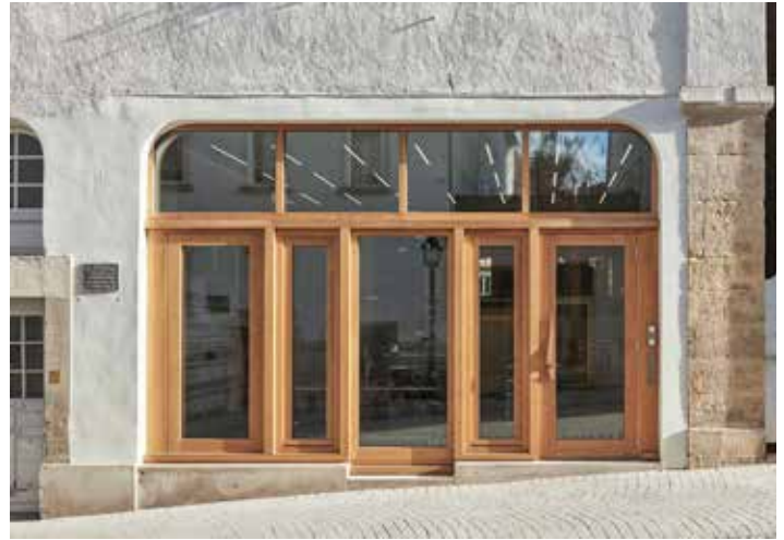
Wie das frühere Ladengeschäft (linkes Foto) öffnen sich auch die neuen Büroräume mit einer vollverglasten schaufensterähnlichen Fensterfront mit Profilen aus geöltem Eichenholz zur Straße hin (rechtes Foto)
