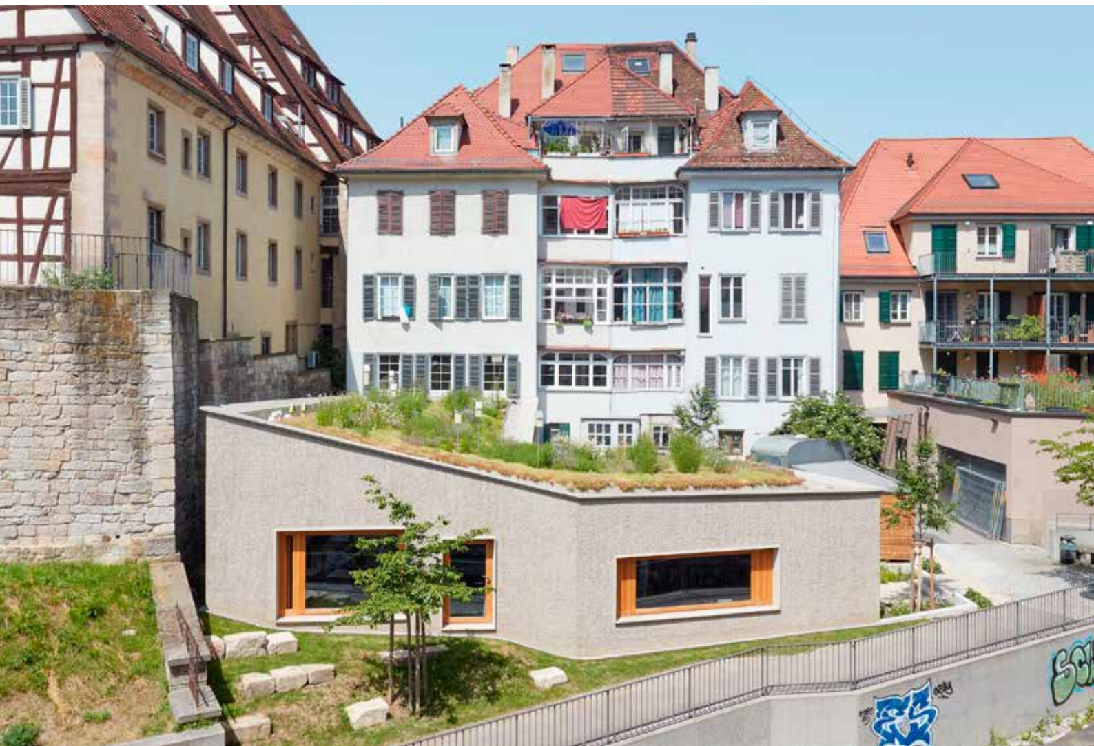
Inmitten der Tübinger Altstadt schließt sich auf der Rückseite des 1789 erbauten Wohn- und Geschäftshauses ein neuer eingeschossiger Anbau an Fotos: Dietmar Strauß
