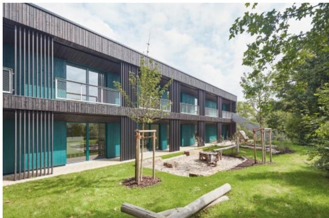
**Bild 2.** Die Laubengang-Fassade der Gartenseite zeigt sich in schwarz geflamtem und leuchtend blaugrün lasiertem Fichtenholz und dunklen Stahlstützen.
