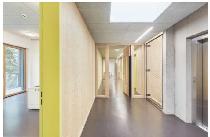
**Bild 7.** Materialbrüche im Treppenhaus: Hier trifft der graue Sichtbeton des Aufzugsschachtes auf helles Fichtenholz und Stahl.
