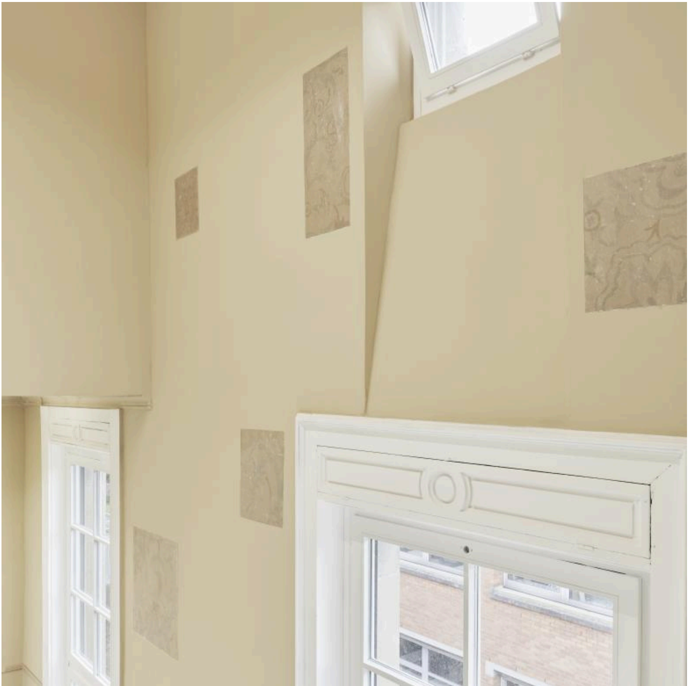
Die verschiedenen Zeitschichten der Bausubstanz wurden freigelegt und die Fragmente des Gebäudes weiterentwickelt. (Foto: Dietmar Strauß)
