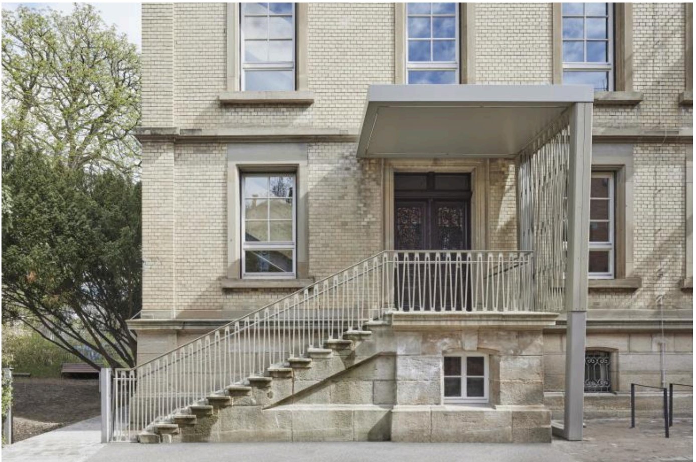
Die Vordachkonstruktion greift die historische Körnung der Fassadenprofilierung des Backsteingebäudes mit seiner Sandsteingliederung auf, interpretiert sie jedoch in einer modernen Formensprache. (Foto: Dietmar Strauß)
