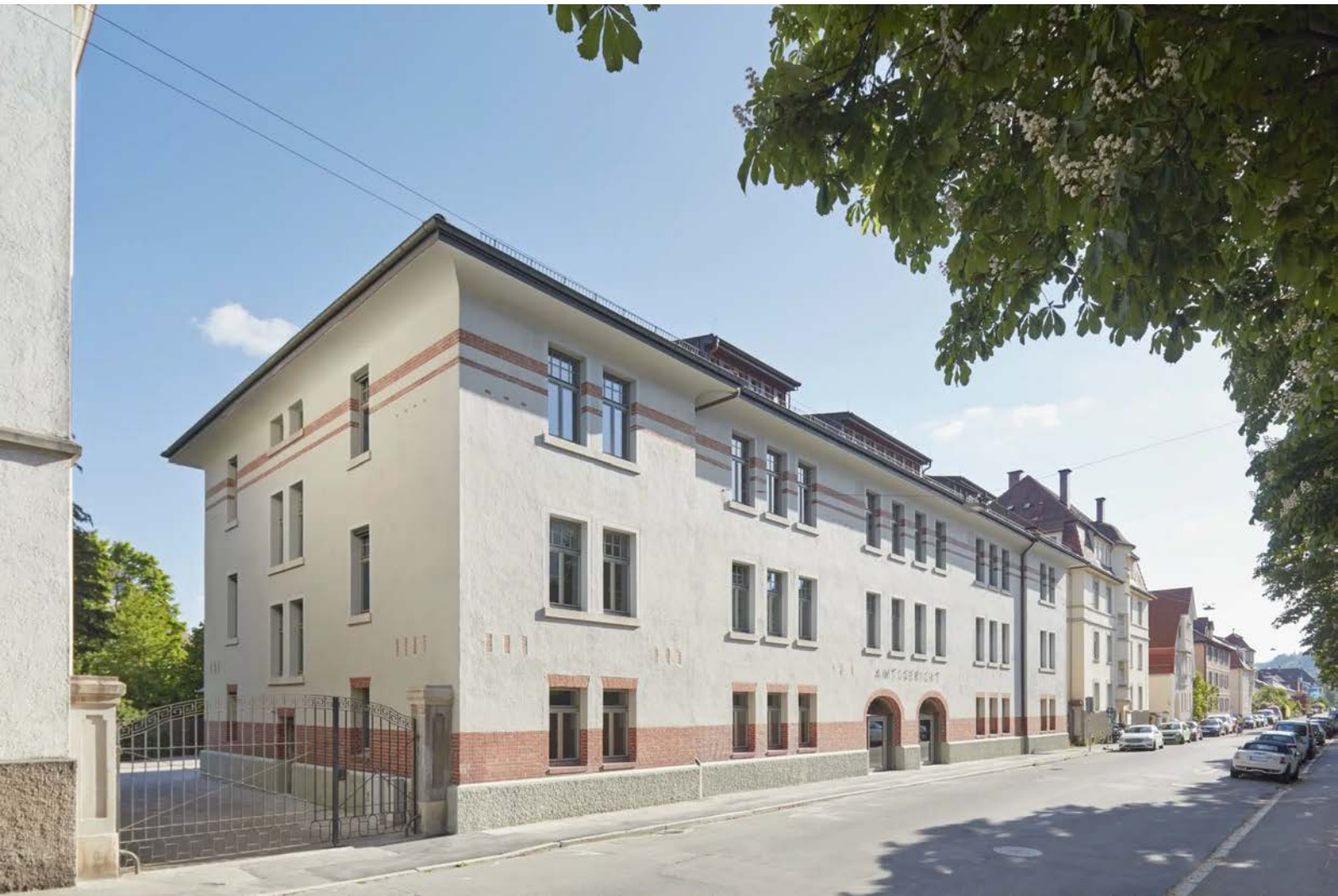
DIE HISTORISCHE FASSADE ZUR SCHELLINGSTRASSE HIN. FOTO: DIETMAR STRAUSS
