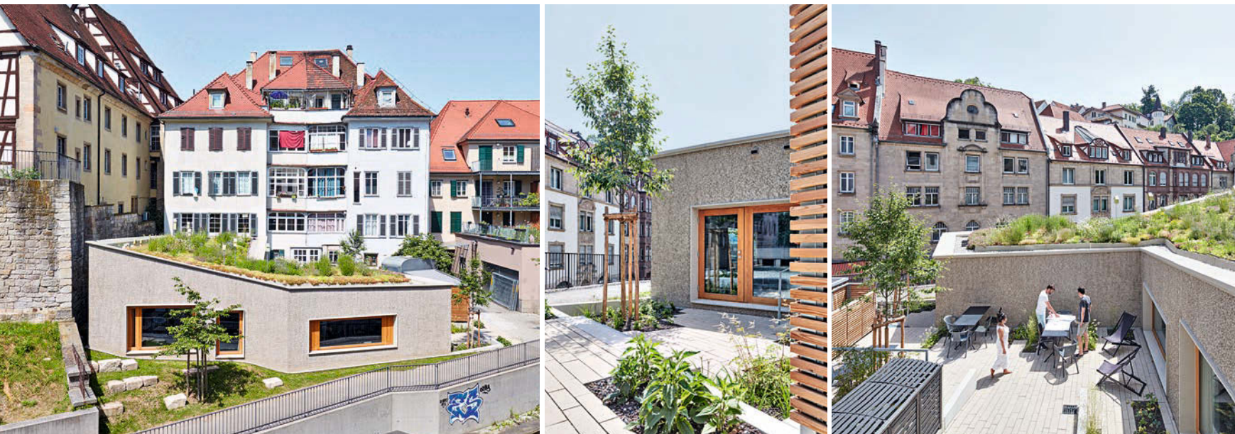
Auf eine selbstbewusste Art fügt sich der Neubau in den historischen Kontext und schließt mit einer gelungenen Raumqualität eine städtebauliche Lücke.
